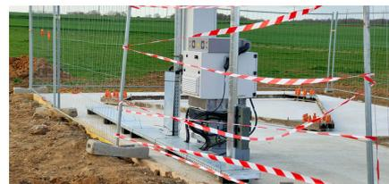
**Dalle coulée - installation et raccordement des armoires électriques**
